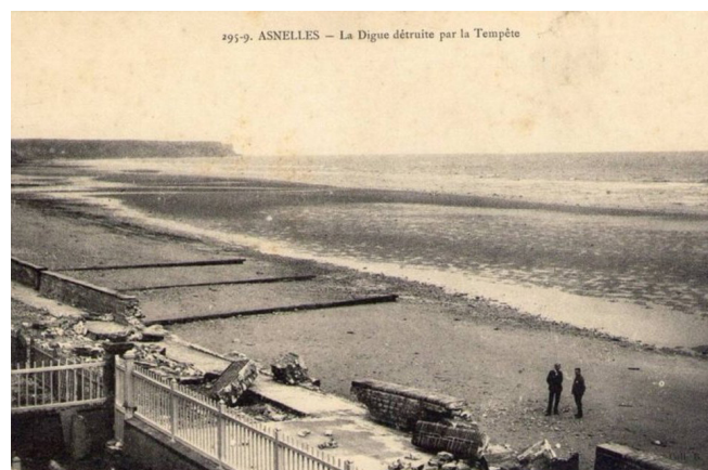
Digue détruite par la tempête (1905)
