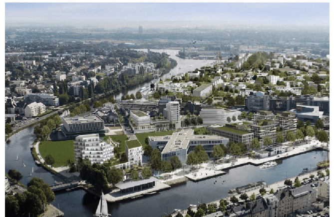
Abandon du projet de construction neuve
