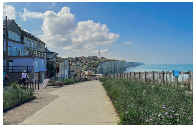
Aménagement d'une promenade
