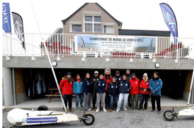
Rénovation du club de Char à voile
