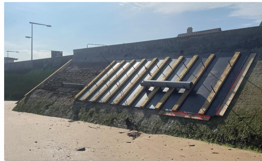
Réfection de voile béton (Asnelles)
