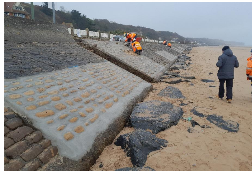
Réfection de joints maçonnés (Vierville-sur-Mer)
